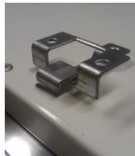
Detail eingehängte Deckenhalter
